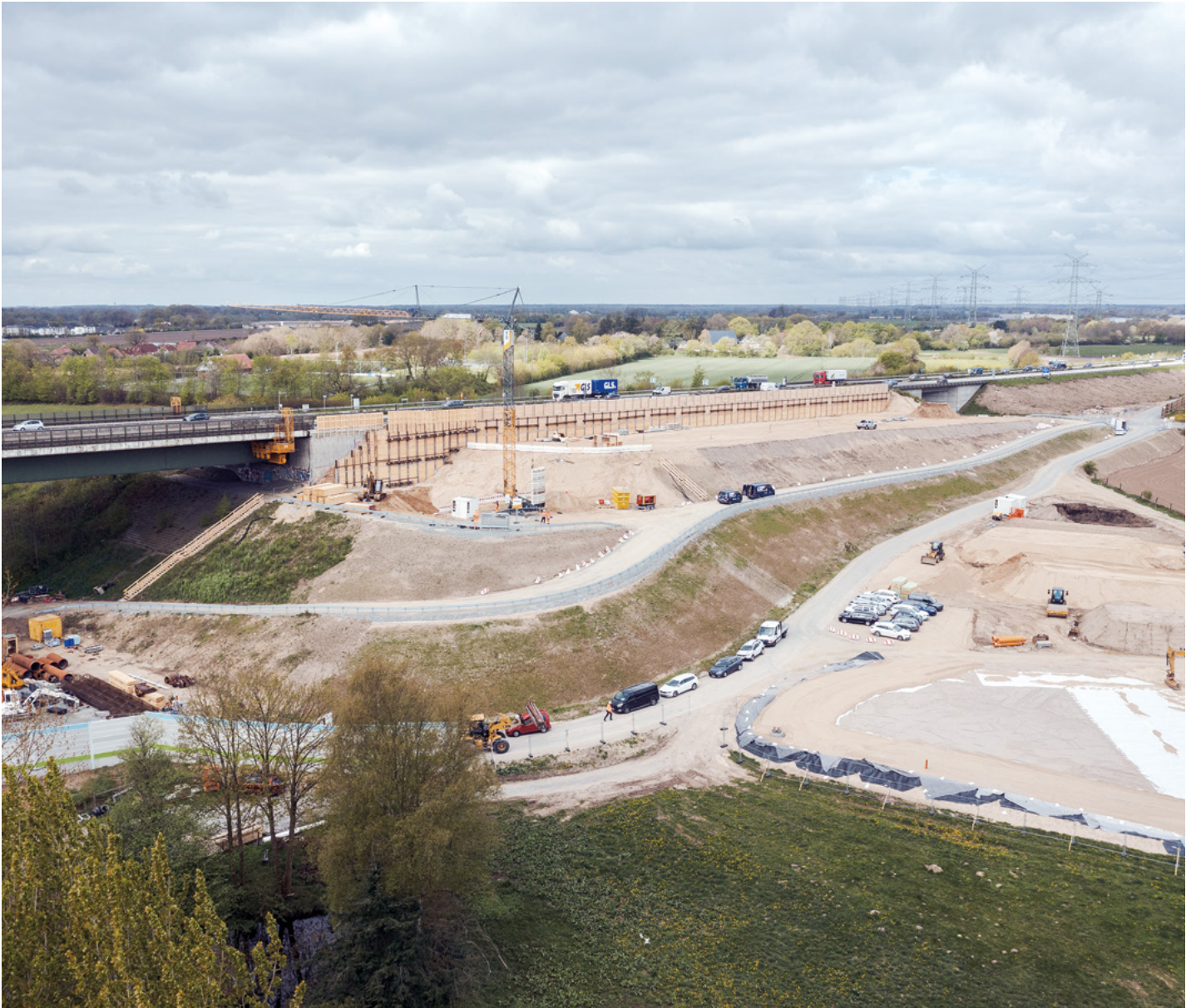
Blick auf die Baustraßen: Ohne sie wäre kein Materialtransport möglich.
