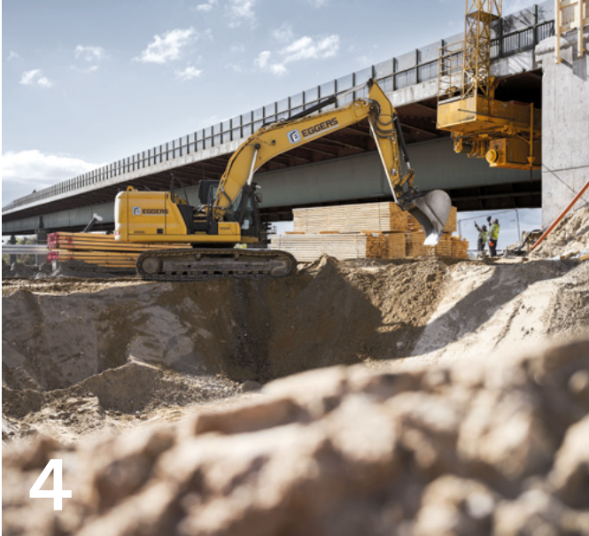
Auf der Baustelle der Rader Hochbrücke.
