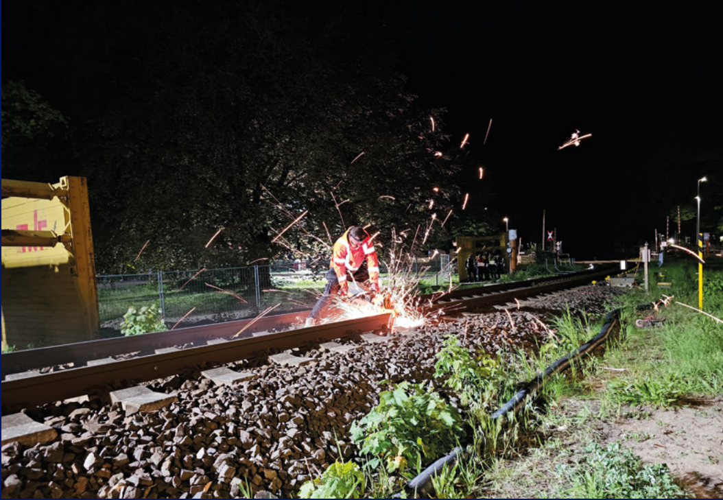
Funkenflug. In den Nachtstunden zu arbeiten, erfordert höchste Konzentration.
